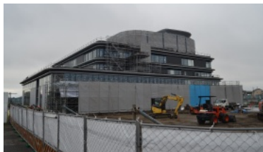
建設中の新庁舎
